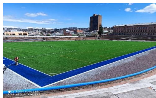
Cancha futbol 11 para el Colegio Mejía en la ciudad de Quito, provincia de Pichincha
